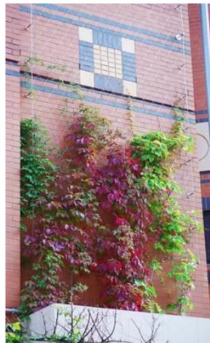
*Les structures grillagées éloignées du mur permettent l'entretien de la façade (exemples de systèmes de fixation par câbles)*
